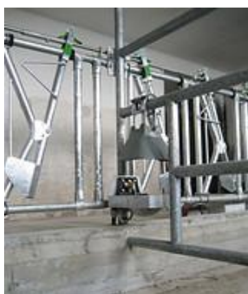
Рисунок 42 – Разделительная решетка (а), хэдлок (б), кормовой забор (в)
